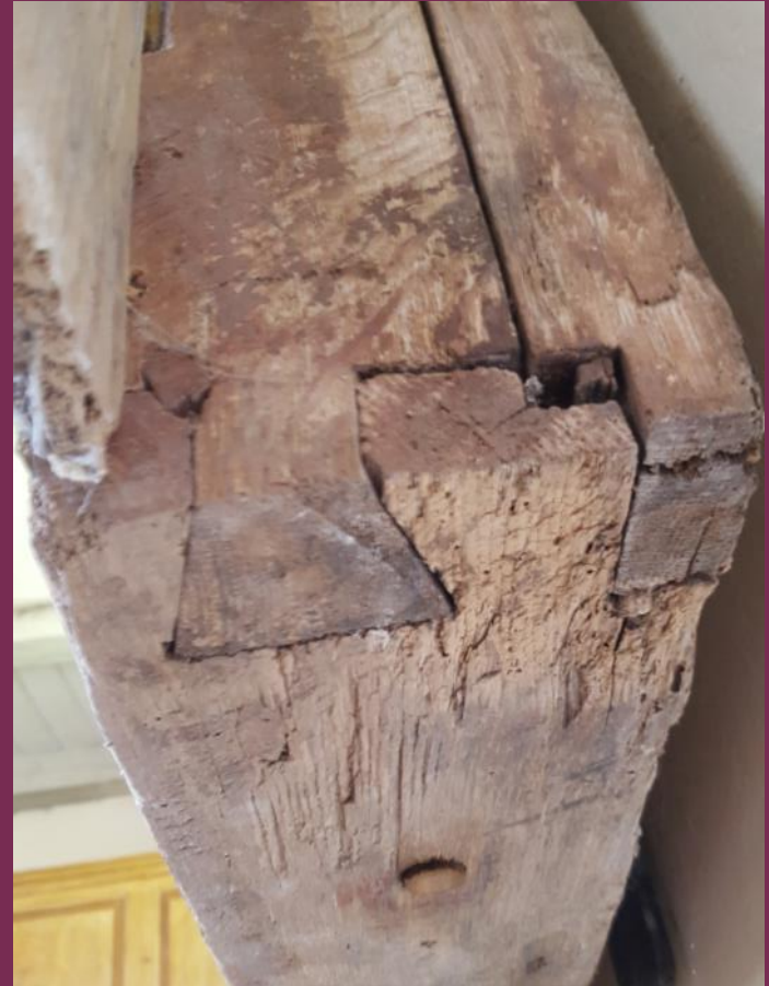
Abb. 19: Eckverbindung der Rahmenezarge mit Schwalbenschwanz, Schrein, Flügelretabel, Ev. Kirche, Laase, Landkreis Rostock
